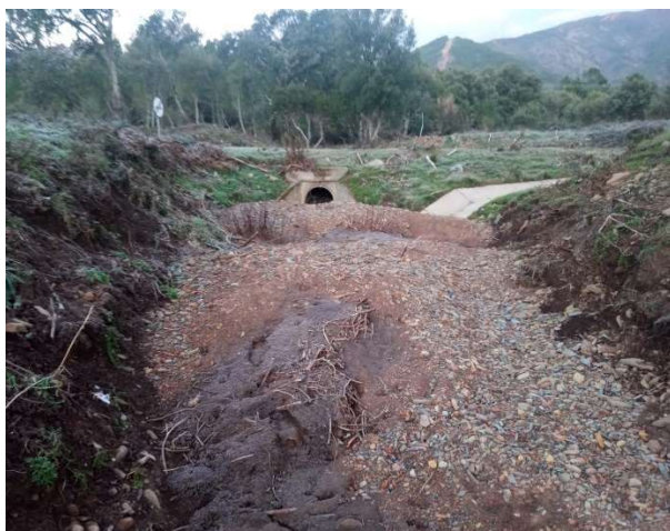
Vista de arrastres aguas arriba de la obra de drenaje
