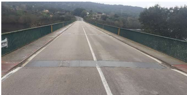
Vista general de las juntas de la estructura
